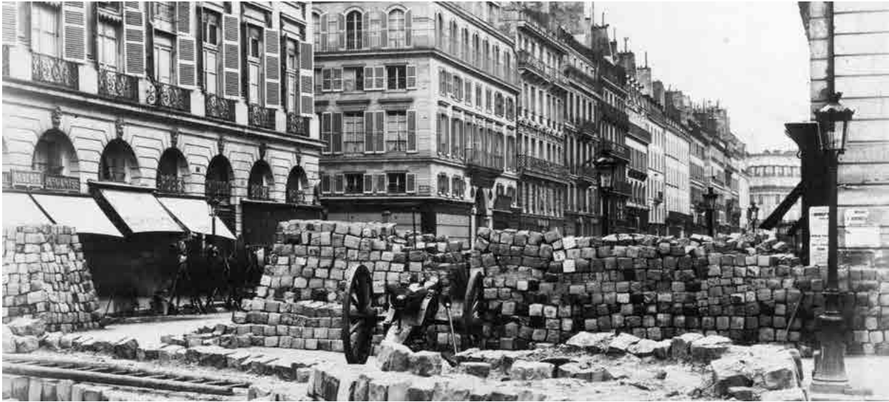
Widerstandsarchitektur aus Pflastersteinen – Barrikade vor der Rue de la Paix am 1. Mai 1871
